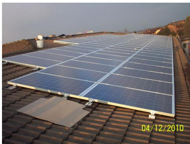
L'impianto fotovoltaico è composto da 86 moduli fotovoltaici che ricoprono una superficie complessiva di 143 m<sup>2</sup>.
