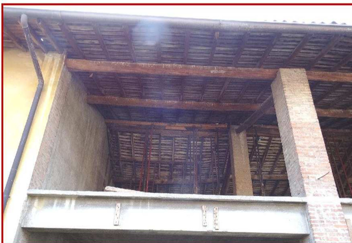
Figura 2 - Stalle: puntelli metallici a sostegno delle travi di colmo
