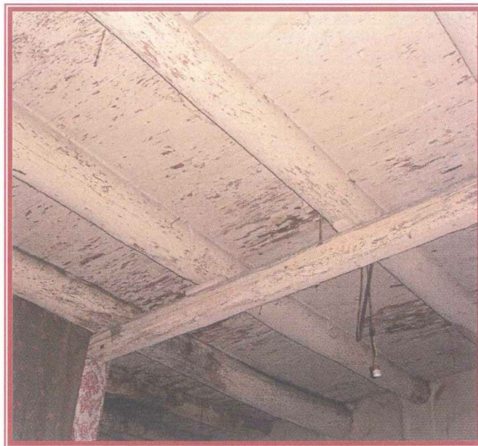
Figura 4 Vista di un solaio interno tinteggiato di bianco.
