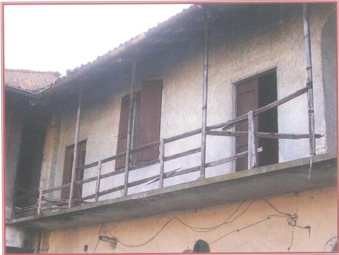
Figura 25 Vista del parapetto in legno esistente.
