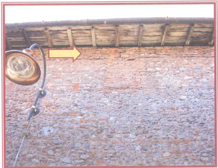
Figura 11. Tamponamento finestre su via Carissoli.
