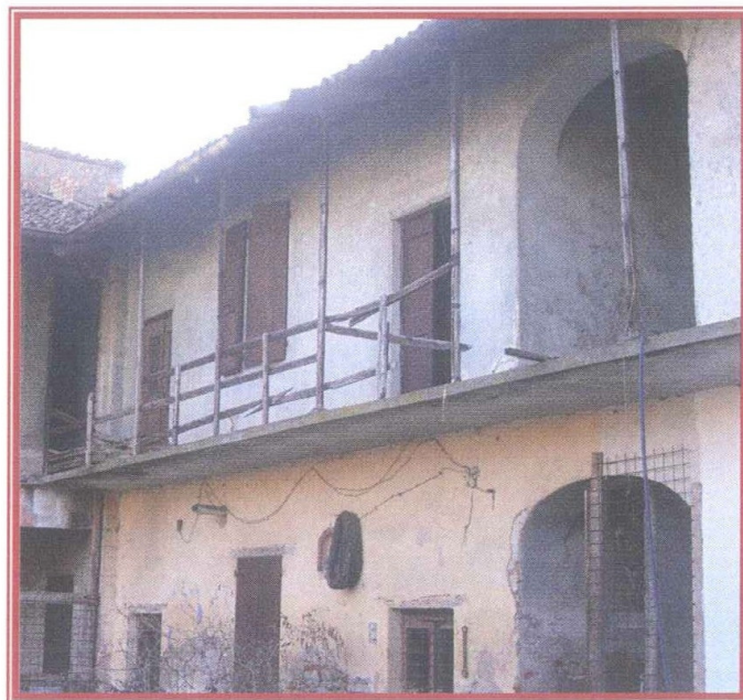
Figura 5 Vista del ballatoio in c.a.
