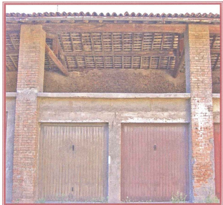
Figura 13 Particolare del tetto e dei pilastri.
