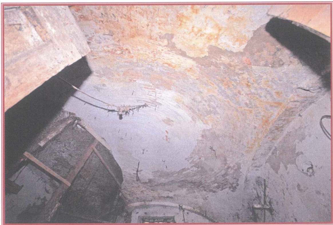
Figura 16 Vista di una volta , con evidente distacco degli strati di tinteggiatura.
