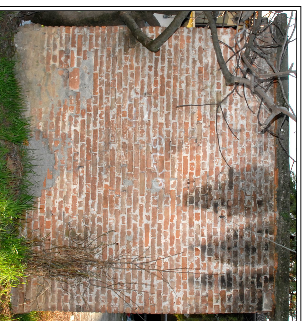
MANUFATTO CON POMPA DELLAQUA LATO NORD
