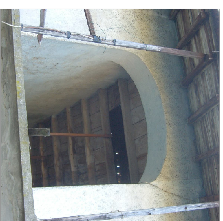
Arco ribassato del vano scala
