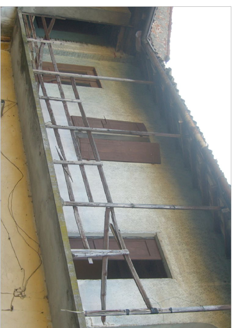
Ballatoio verso corte con parapetto in legno
