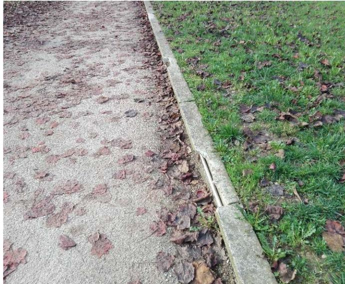
5. Sistemazione del vialetto pedonale dalla piazzola attrezzata con panchine in lato nord-ovest sino alla S.P. 591 per raggiungere l'attraversamento pedonale, con rimozione e riposizionamento delle esistenti lastre in pietra, modificando leggermente la traiettoria, "allontanandolo" dal vicino albero, c/o la panchina, che con le proprie radici ha alterato la planarità dello stesso vialetto;
