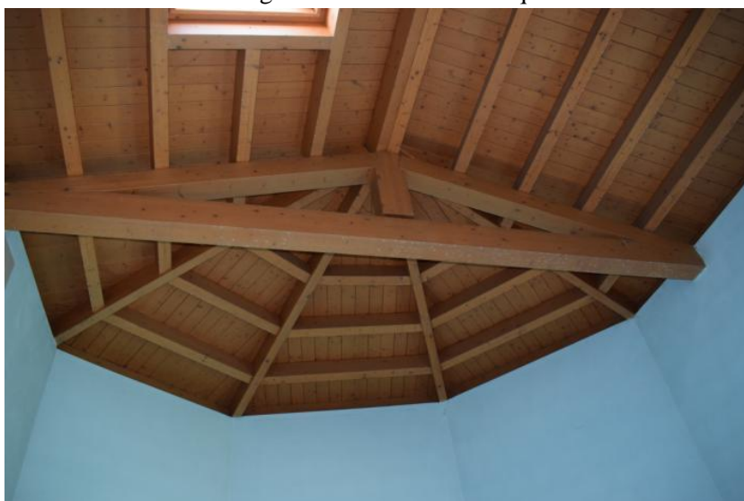
Immagine 10 Vista dell'intradosso della copertura
