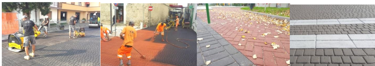
Pavimentazione in asfalto impresso: 1 - Fase di imprimitura con matrici 2 - Fase di resinatura 3 e 4 - Esempi di pavimentazioni ultimate
