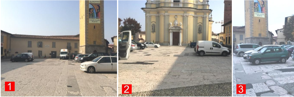
1 - Piazza Agliardi – fronte chiesa 2 – Piazza Agliardi – fronte opposto 3 – Piazza Agliardi - degrado
