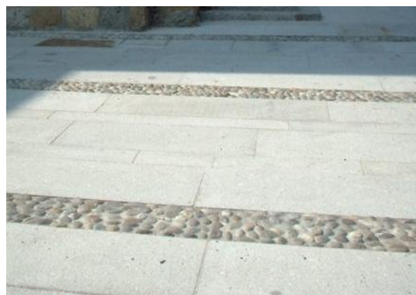
1 - Esempio di realizzazione di pavimentazione in cubetti di porfido e fasce in acciottolato - Vilminore di Scalve 2 - Esempio di pavimentazione a lastre con fasce in acciottolato - Olmo al Brembo
