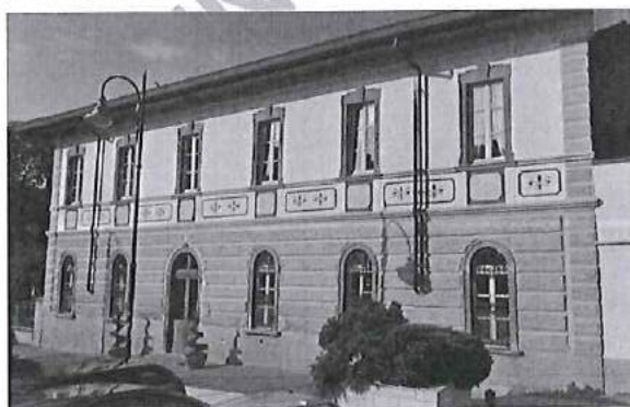
Accessi carrali e pedonali all'asilo di piazza Cavour
