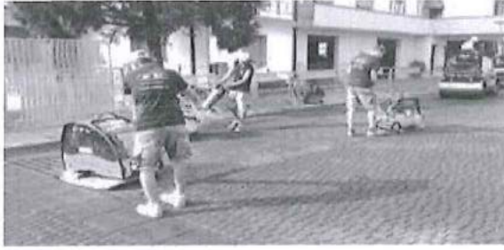
formazione di pavimentazione in "Asfalto Stampato" attraverso intervento di imprimitura
