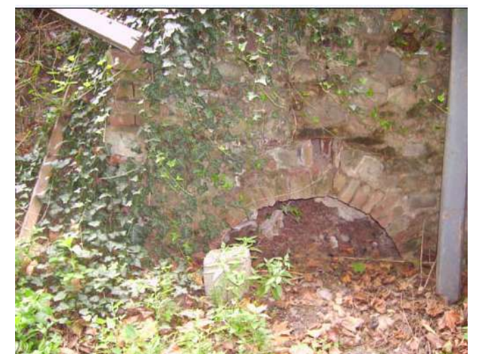
Particolare dell'archetto in laterizio con muratura in borlanti di fiume (foto Beretta).
