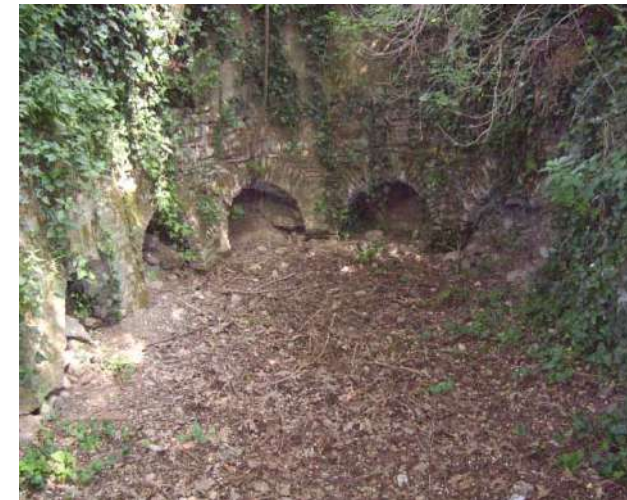
Manufatto architettonico ad archi a tutto sesto in laterizio a doppio ordine, che costituisce l'arginatura del capofonte (foto Beretta).
