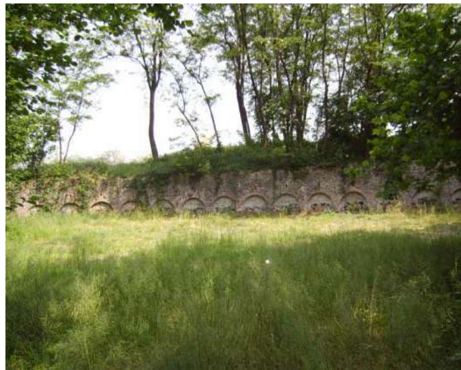
Struttura ad archi in laterizio e borlanti di fiume che circonda l'argine del capofonte (foto Beretta).
