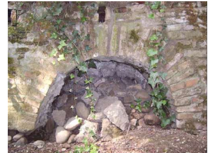
Particolare dell'arco in laterizio con foro superiore detto "troppo pieno" (foto Beretta).
