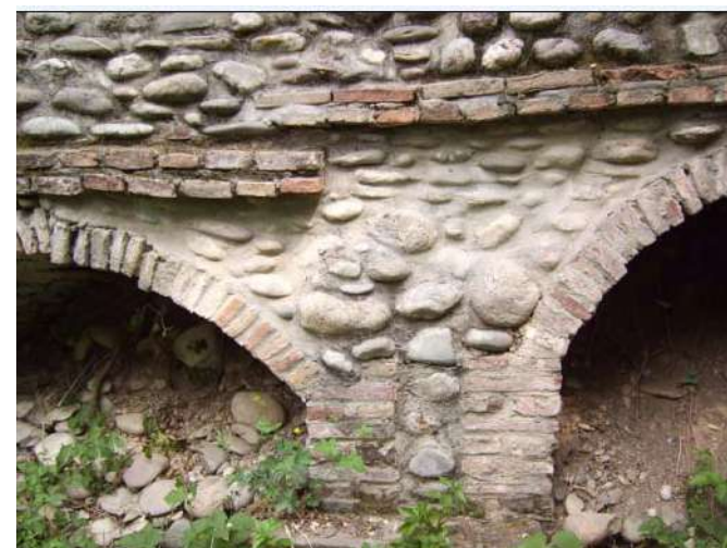
Particolare della doppia fila di ricorsi orizzontali in laterizio presenti nella struttura sopra gli archetti (foto Beretta).
